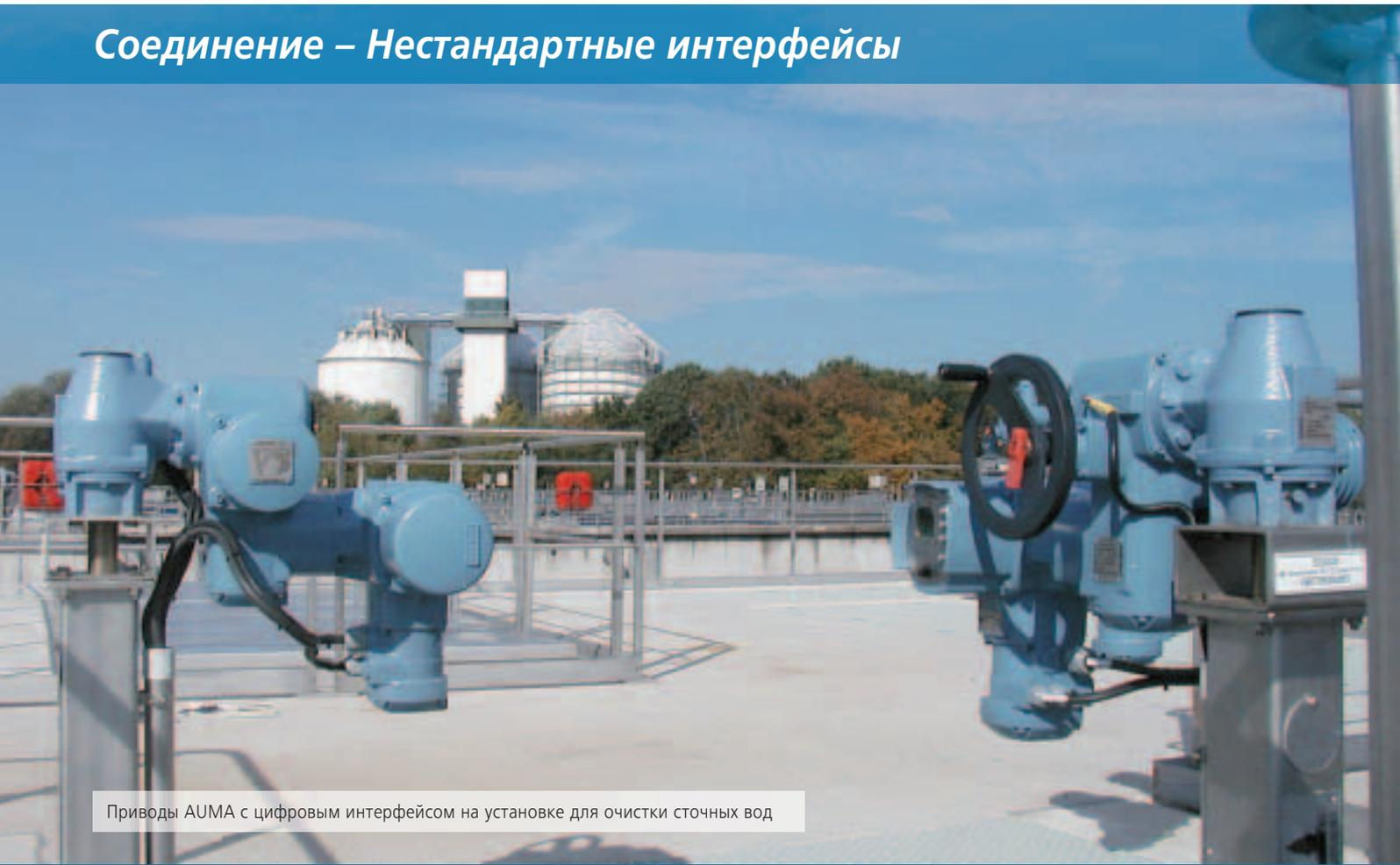
Приводы AUMA с цифровым интерфейсом на установке для очистки сточных вод
